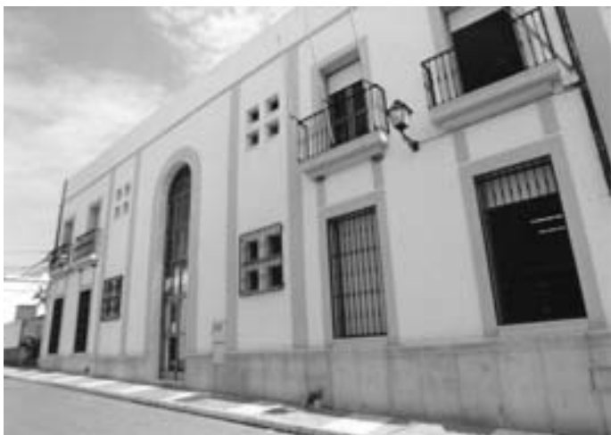
Fachada de la Casa de la Cultura, sita del IES
